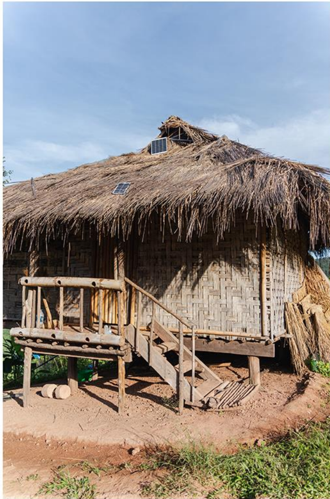
B16 ชื่อภาพ หลังคาเซลล์สุริยะ Solar Cell Roof สถานที่และประเทศที่ถ่ายภาพ น่าน ไทย Nan, Thailand ผู้ถ่ายภาพ บัณฑิต สัตย์เพริศพราย Bundit Satpretpry สถาบัน มหาวิทยาลัยรามคำแหง Ramkhamhaeng University
